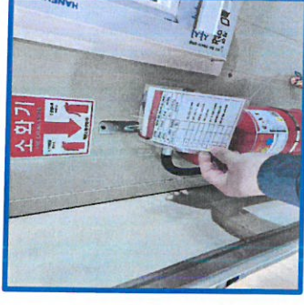
소화기 점검 양호
