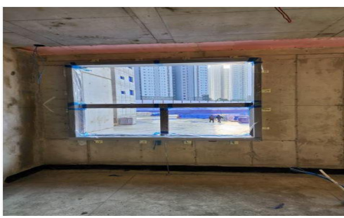
창틀 설치 후 보양
