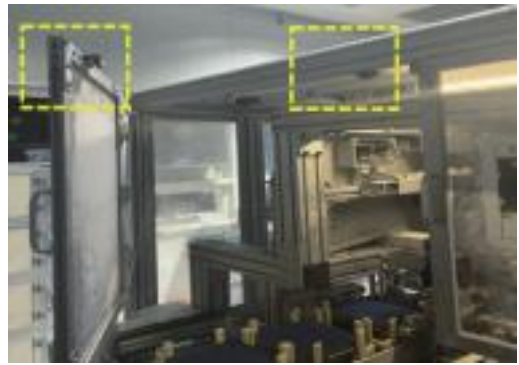
개선 후 (인터락 설치)
