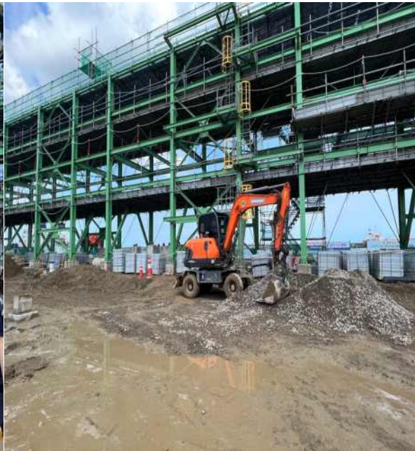
[사진4] 골재 포설 작업 중이던 굴착기
