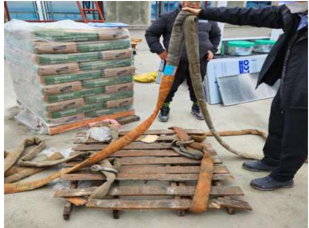
[사진2] 파손된 양중물(조적자재) 팔레트
