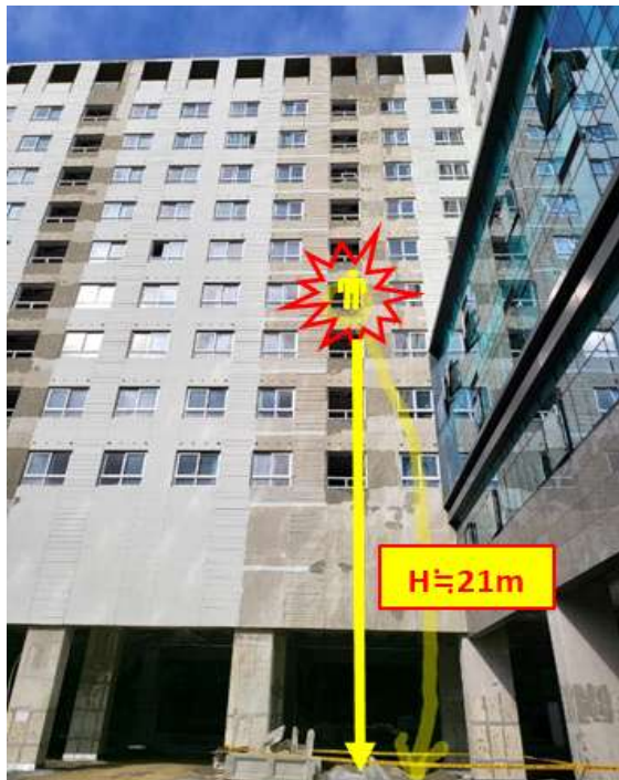
[사진1] 재해 발생구간 전경
