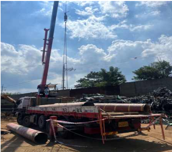
[사진1] 재해발생현장 전경
