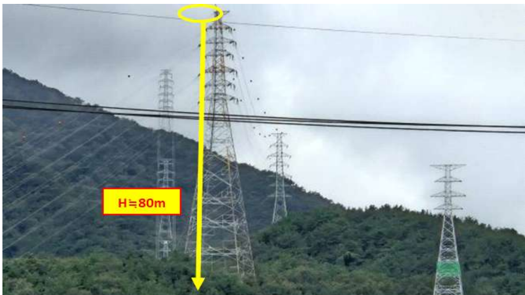
[사진] 재해발생 장소 전경
