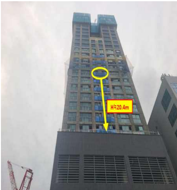
[사진1] 재해 발생구간 전경
