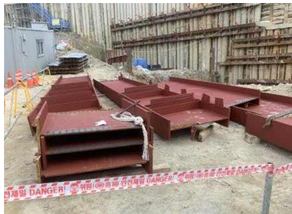
[사진2] 지상에 적재된 H-BEAM 4본
