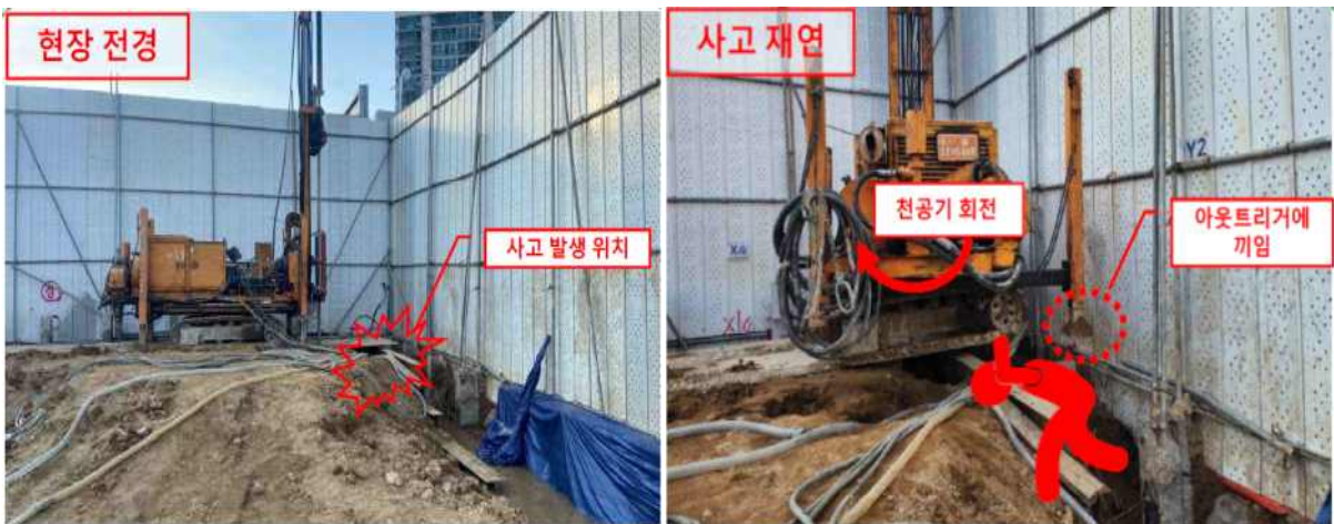
[사진1] SGR 차수 작업 전경
