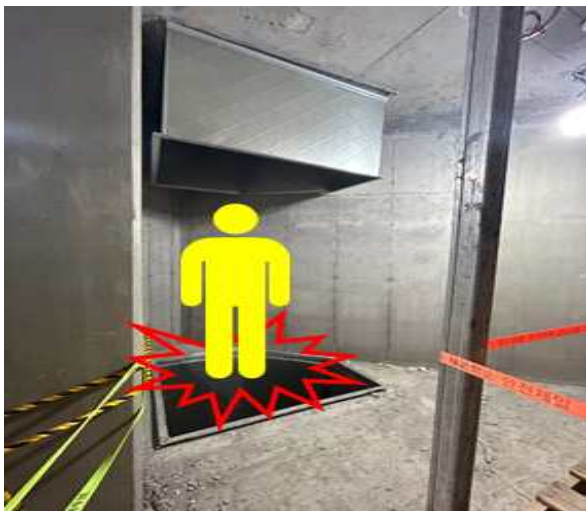
[사진1] 재해발생 장소 전경
