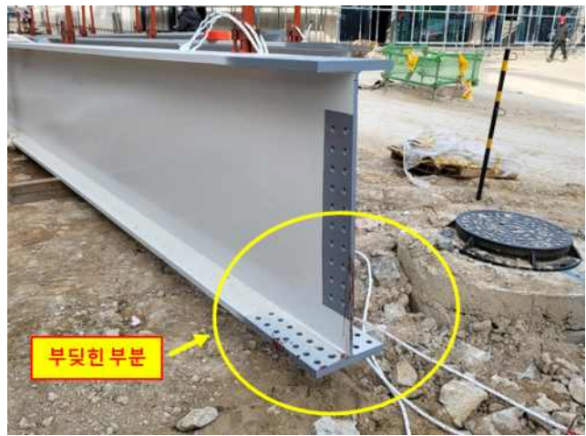
[사진2] 기인물 철골 거더
