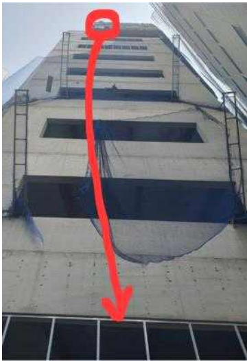
[사진1] 사고 발생 현장 전경
