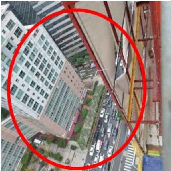
[사진1] 재해발생 장소 전경1
