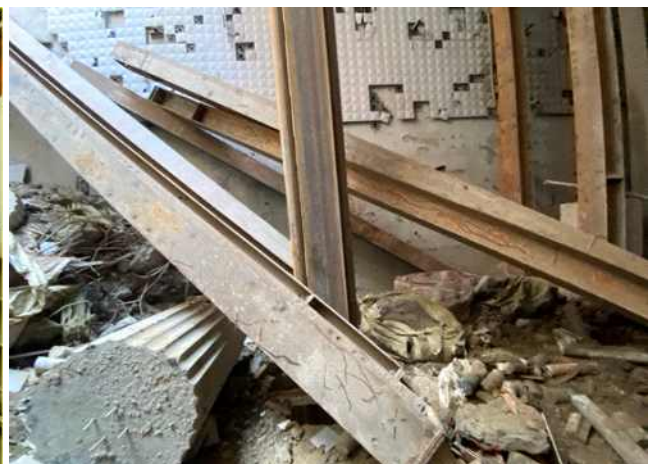
[사진2] 해체 후 쌓아놓은 보강재
