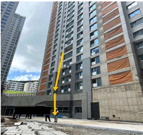
[사진1] 사고발생 장소 전경
