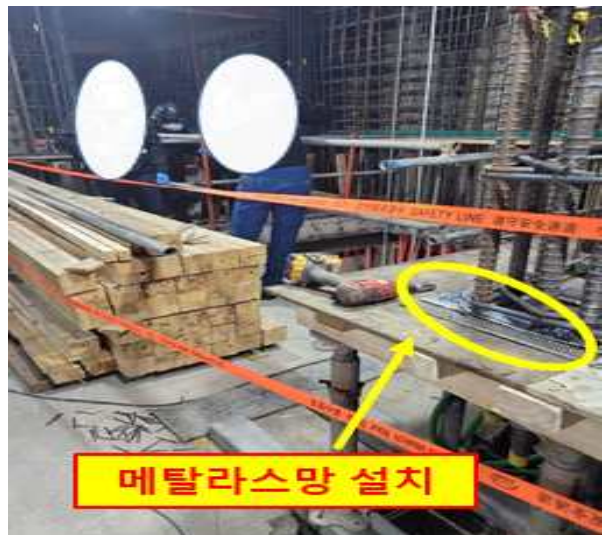
[사진2] 메탈라스망 설치 구간
