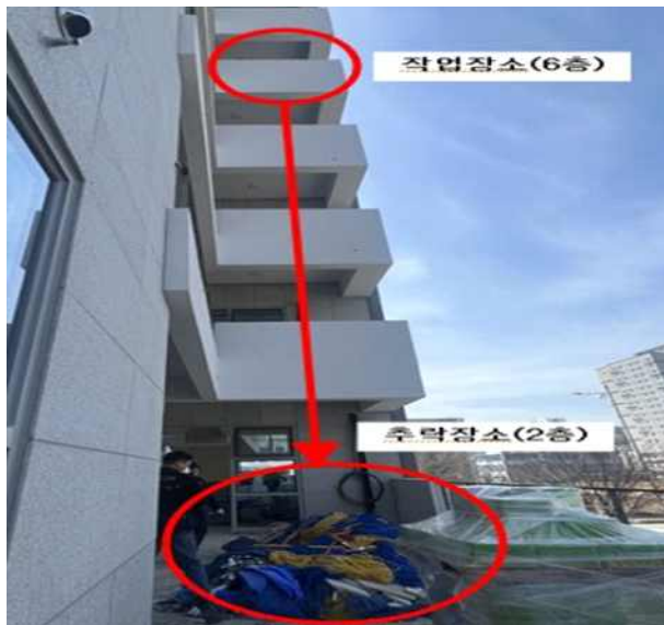
[사진1] 재해발생현장 전경
