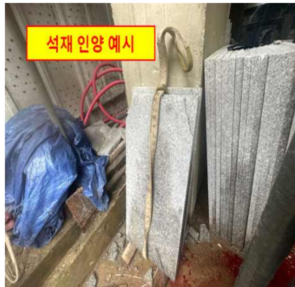
[사진2] 재해 당시 석재 인양 예시
