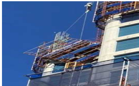
[사진2] 1줄걸이로 기울어진 갱폼
