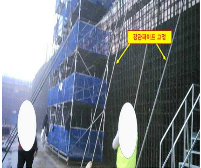
[사진4] 사고 전 벽체 철근지지용 강관파이프 설치상태
