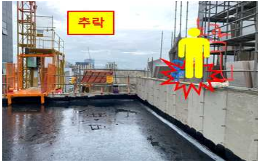
[사진] 재해발생 장소 전경
