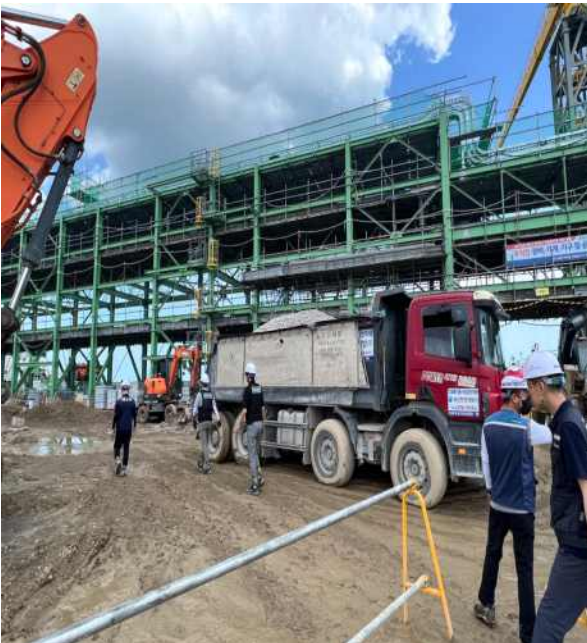
[사진3] 골재를 싣고 후진 중이던 덤프트럭
