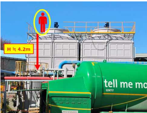
[사진1] 재해발생현장 전경
