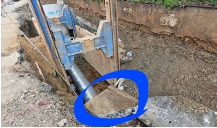
23.9.11.(월) 경기 용인시 소재 (주)장안에서 시공하는 「민간공원 조성사업 중 공원공사」 현장에서 우수관로 매설을 위한 T/S판넬(간이 흠막이) 설치 작업 중 기존에 있던 석축이 무너지면서 하부(깊이 약 2미터)에 있던 재해자가 석축에 깔려 사망
