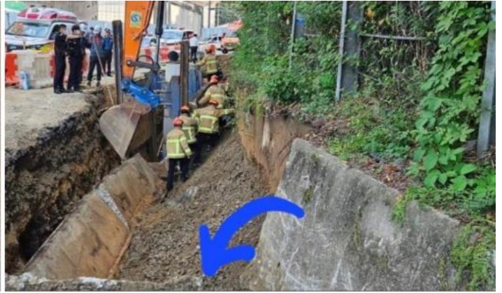
23.9.11.(월) 경기 용인시 소재 (주)장안에서 시공하는 「민간공원 조성사업 중 공원공사」 현장에서 우수관로 매설을 위한 T/S판넬(간이 흠막이) 설치 작업 중 기존에 있던 석축이 무너지면서 하부(깊이 약 2미터)에 있던 재해자가 석축에 깔려 사망
