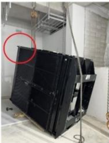
전기실 바닥에 추락한 라디에이터의 모습(빨간 원 부분 연결 러그 위치) 라디에이터의 연결 러그가 찢어진 모습
