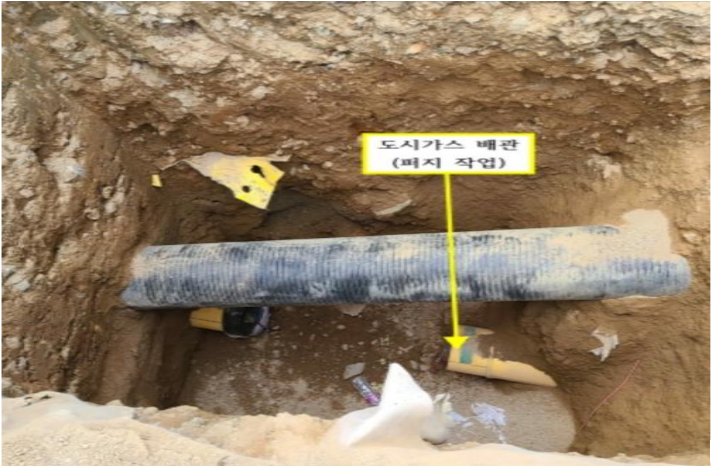
22.6.7. 경기 화성시 오산동 소재 도시가스배관 이설공사 현장에서 굴착피트 내부에서 도시가스관 철거를 위해 절단된 배관 내부를 퍼지작업 중 질식되어 치료 중 사망
