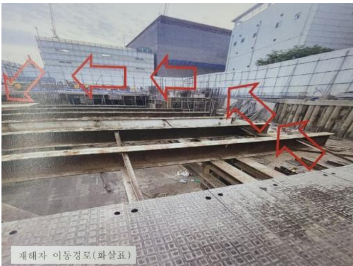
23.6.6.(화) 14:10경 「○○동 오피스텔 신축공사」 현장에서 재해자가 떨어진 흙막이가시설 연결볼트 수집 및 바닥 정리작업 후 지상1층 현장 출입구로 가던 중 해체된 복공판 구간 스트러트 사이로 추락(약 3미터)하여 두부 손상으로 치료 중 사망
