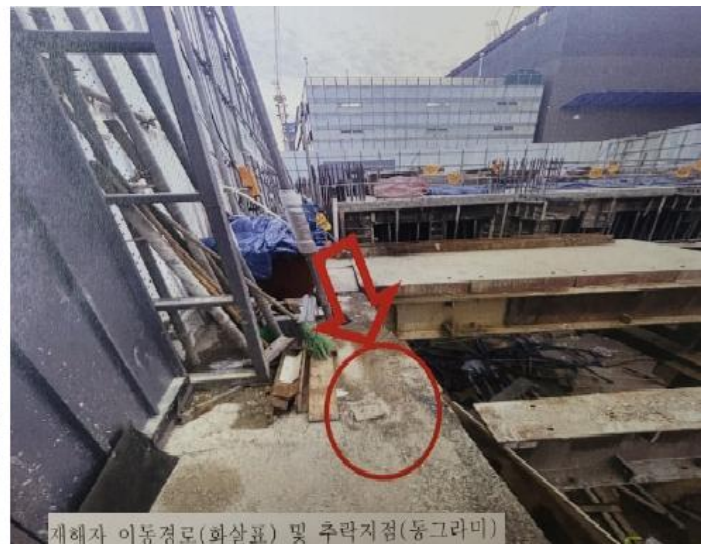
23.6.6.(화) 14:10경 「○○동 오피스텔 신축공사」 현장에서 재해자가 떨어진 흙막이가시설 연결볼트 수집 및 바닥 정리작업 후 지상1층 현장 출입구로 가던 중 해체된 복공판 구간 스트러트 사이로 추락(약 3미터)하여 두부 손상으로 치료 중 사망
