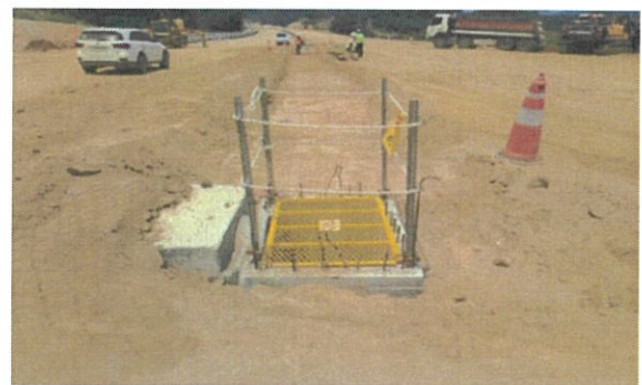
집수정 개구부 덮개 및 안전시설 설치 우수 (3공구)
