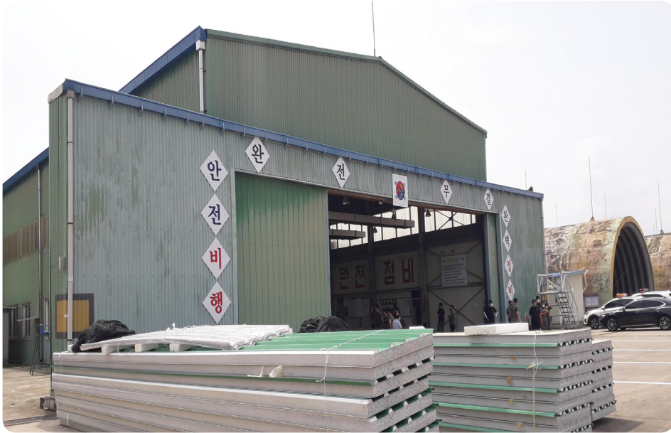
[사진1] 재해발생 현장전경
