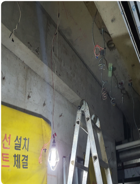
[사진2] 재해자가 수리 작업중이던 전등 및 설치된 가설분전반 모습
