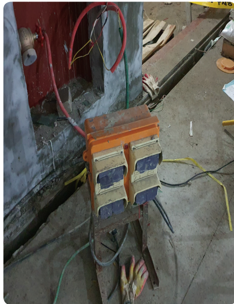
[사진2] 재해자가 수리 작업중이던 전등 및 설치된 가설분전반 모습
