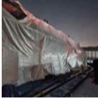
[콘크리트 보온양생 장소]
