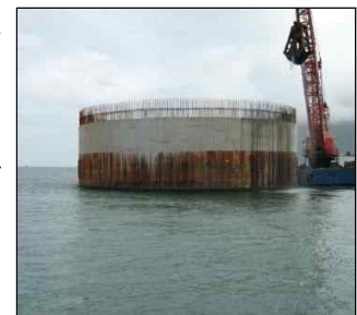
교량 우물통 공사
