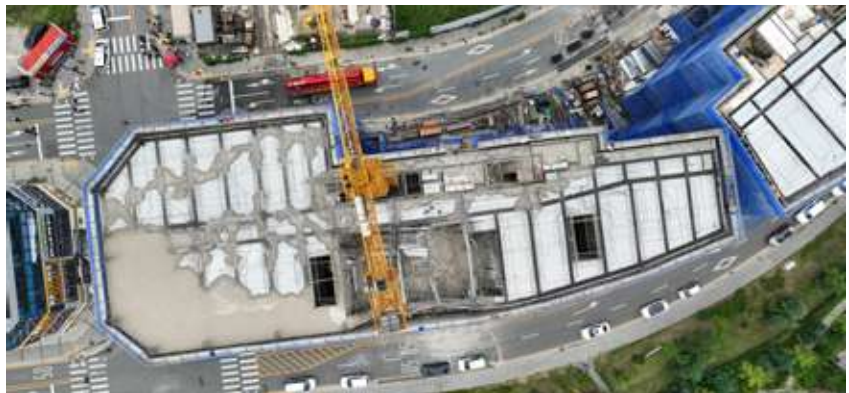
빨간색 펌프카와 타워크레인 위치가 서로 간섭되도록 배치됐다
