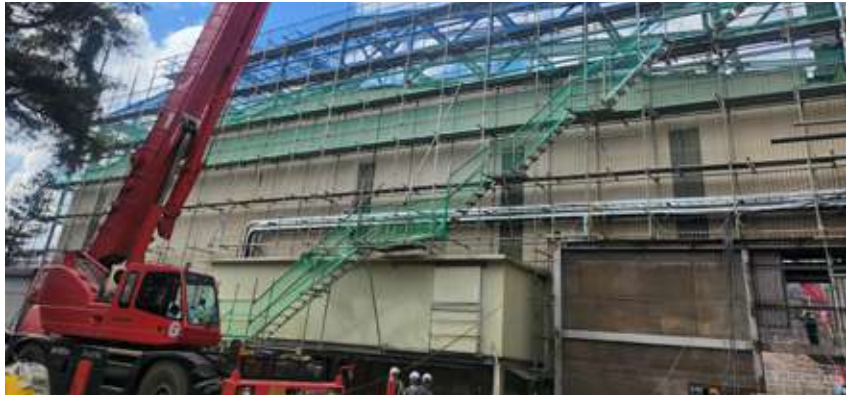
수직방망 설치 후 작업 현장 | 2024년 2월 26일
