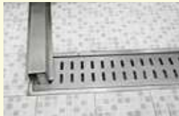
배수로 덮개(트렌치) 설치
