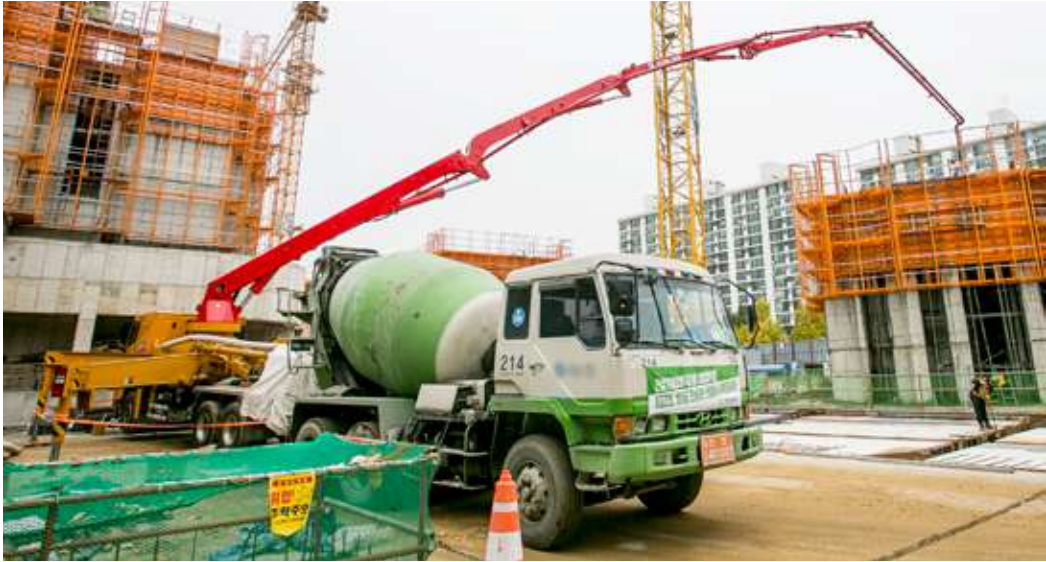
콘크리트 타설 준비 중인 믹서트럭과 펌프카. 재해 현장과는 무관하다
