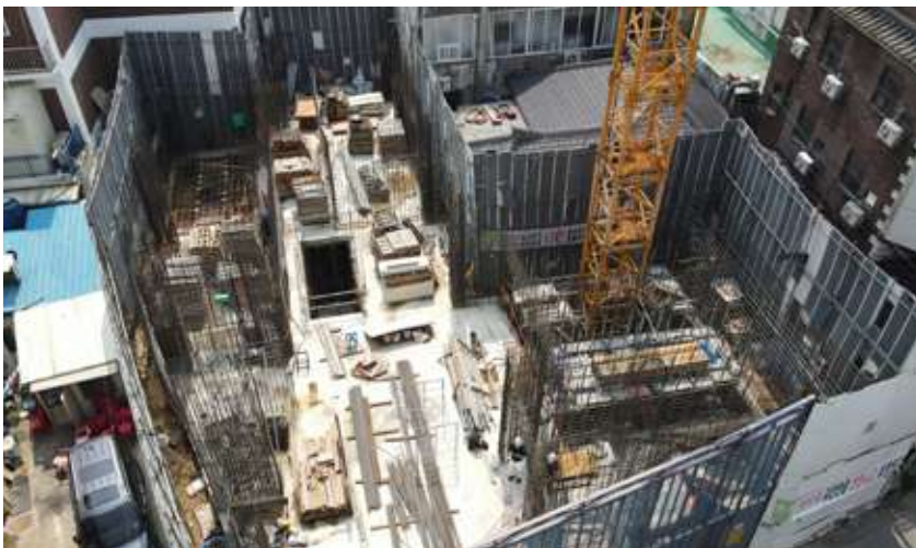
당시 공사 현장
