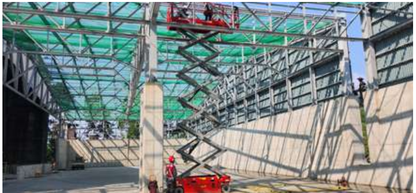
지붕 수리 작업 전 추락방호망 설치 현장 | 2024년 5월 31일
