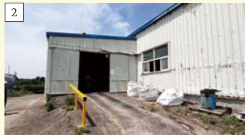
2. 지게차가 오가는 비탈에 지게차 넘어짐 사고를 막기 위해 가드레일을 설치했다
