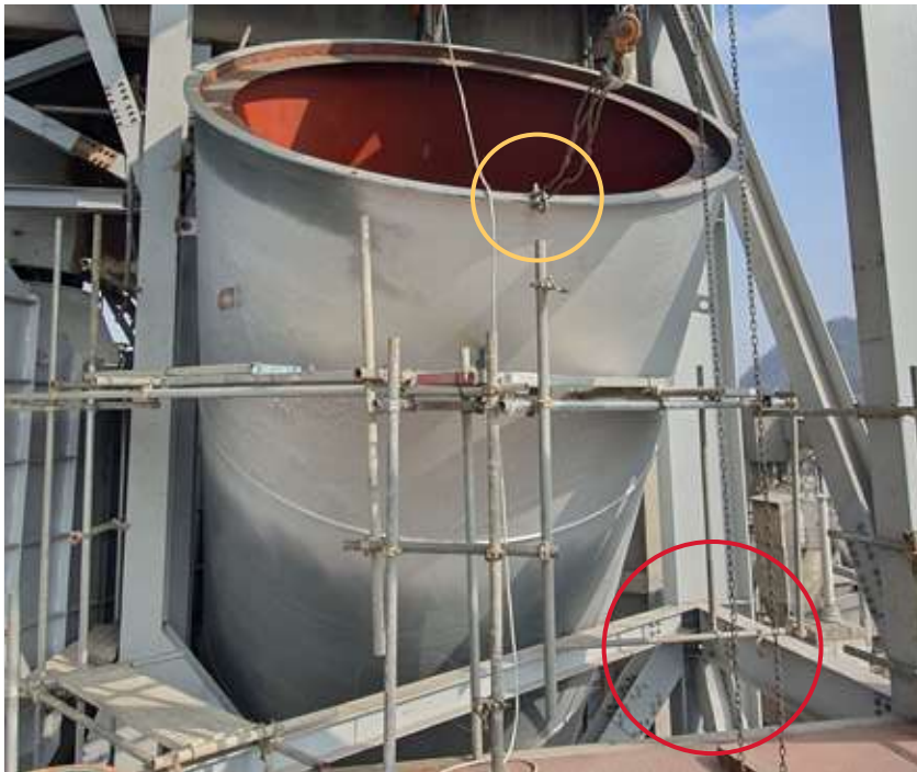
노란 원 부분에 안전대 고리를 결속하려다 추락한 것으로 추정. 붉은 원이 재해자가 서 있던 개구부
