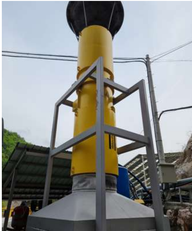
석회석 광업소 주 송풍기 배기구. 갱도 입구 부근에 설치된 주 송풍기는 계속 가동되었으나 갱도 내 송풍기는 발파 작업 시 중단되었다
