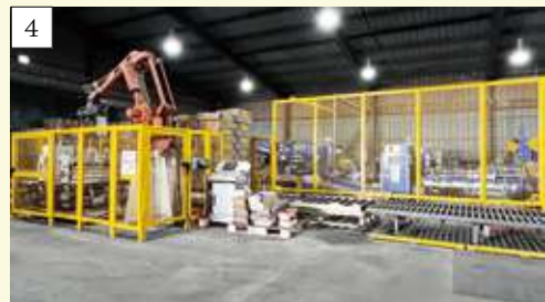
4. 로봇과 컨베이어벨트에 설치된 울타리는 인근 작업 시 부딪힘을 방지한다
