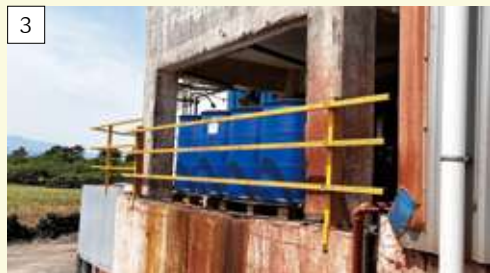
3. 작업 중 추락을 예방하기 위해 안전난간을 설치했다
