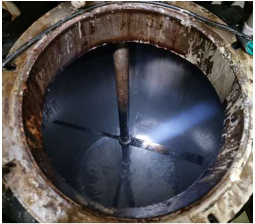
사고 발생 탱크 내부 임펠러 모습
