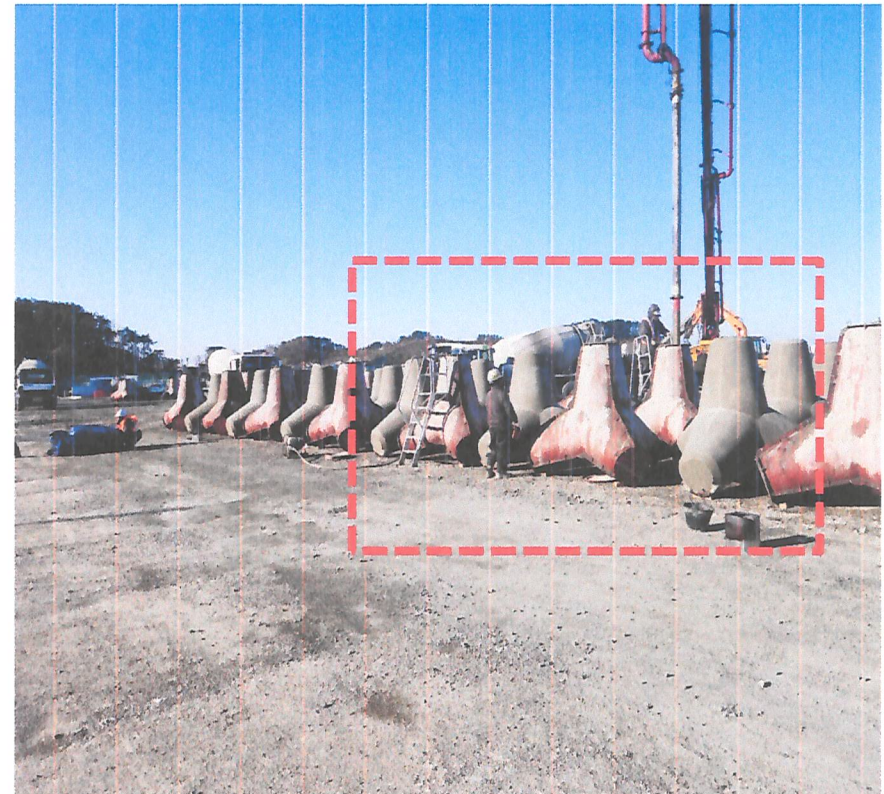
② 작업계단 설치
