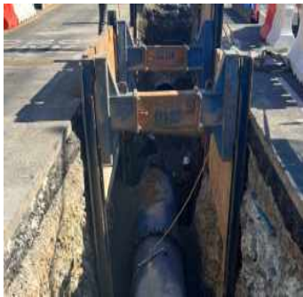
< 관로공사 흙막이 지보공 설치 예시 >
