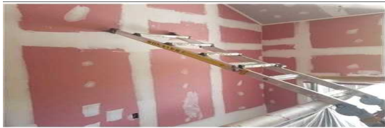
추정 작업 방법(3층 사다리)
