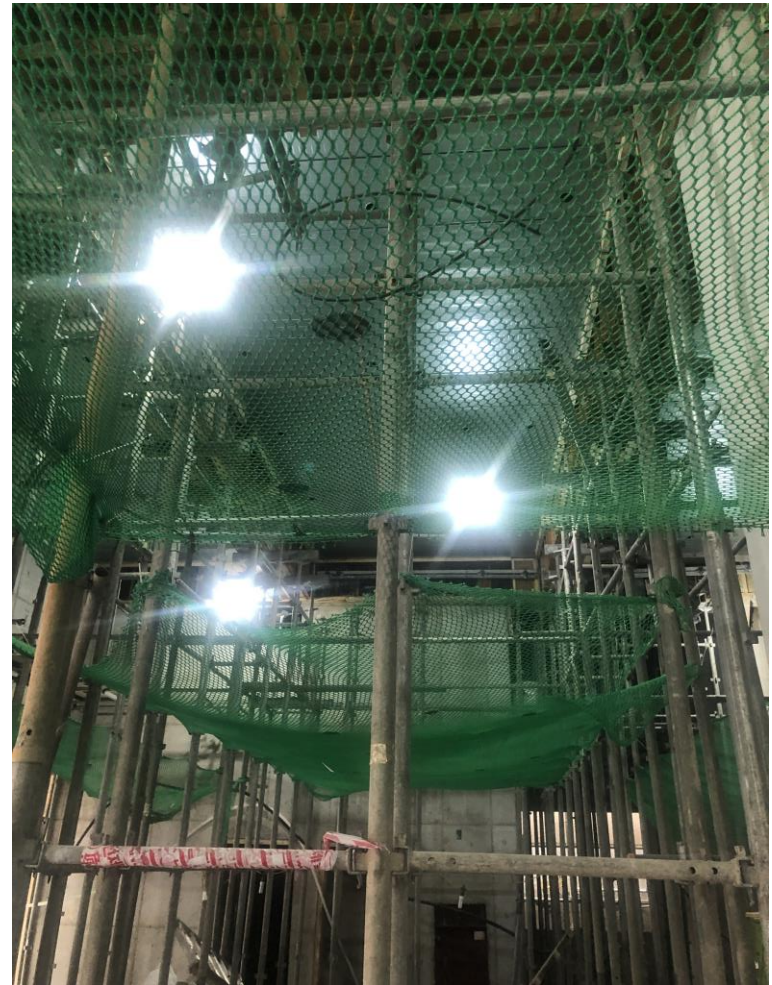
시스템동바리 낙하물방지망 설치 우수
