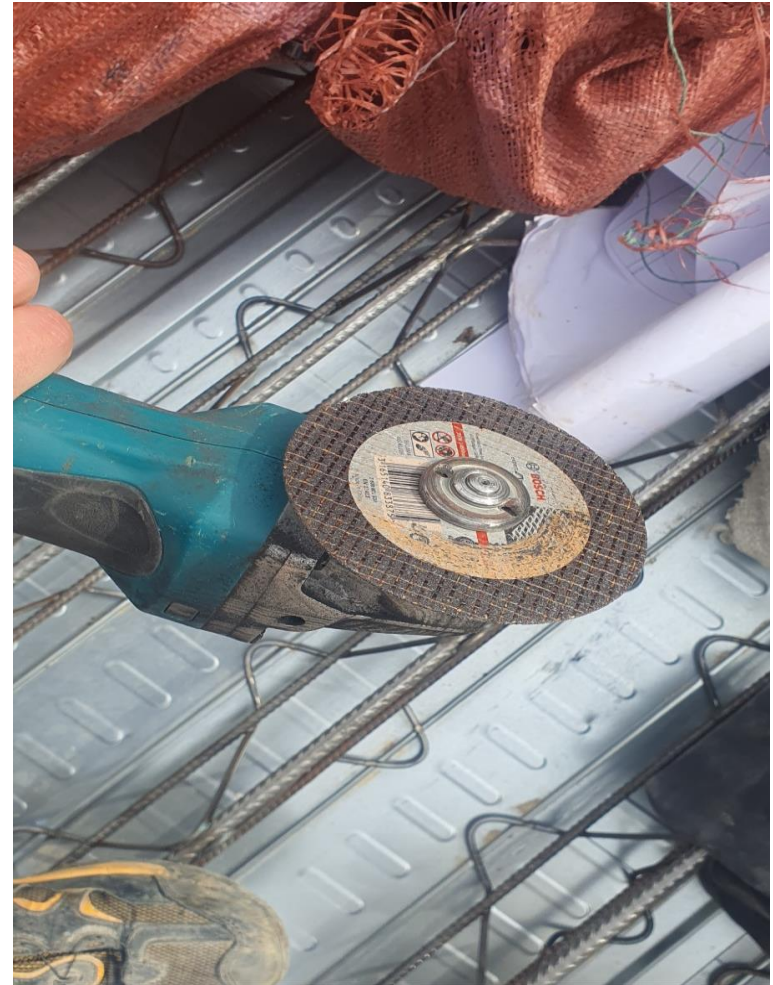
핸드그라인더 보호커버 미설치
