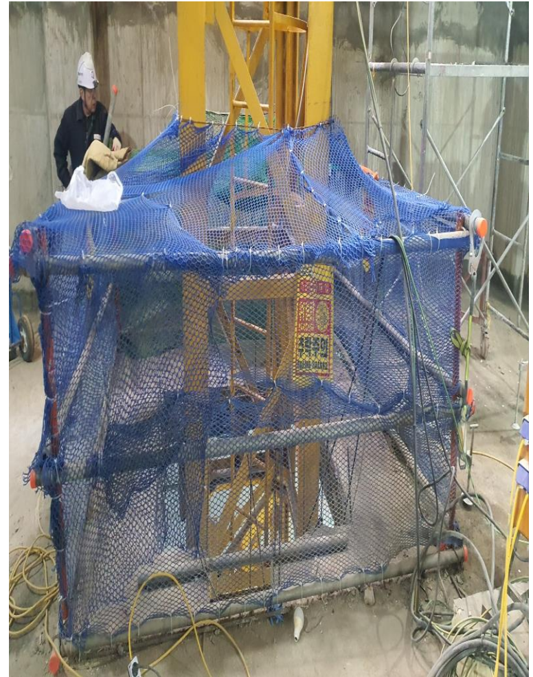
타워크레인 방호조치 우수
