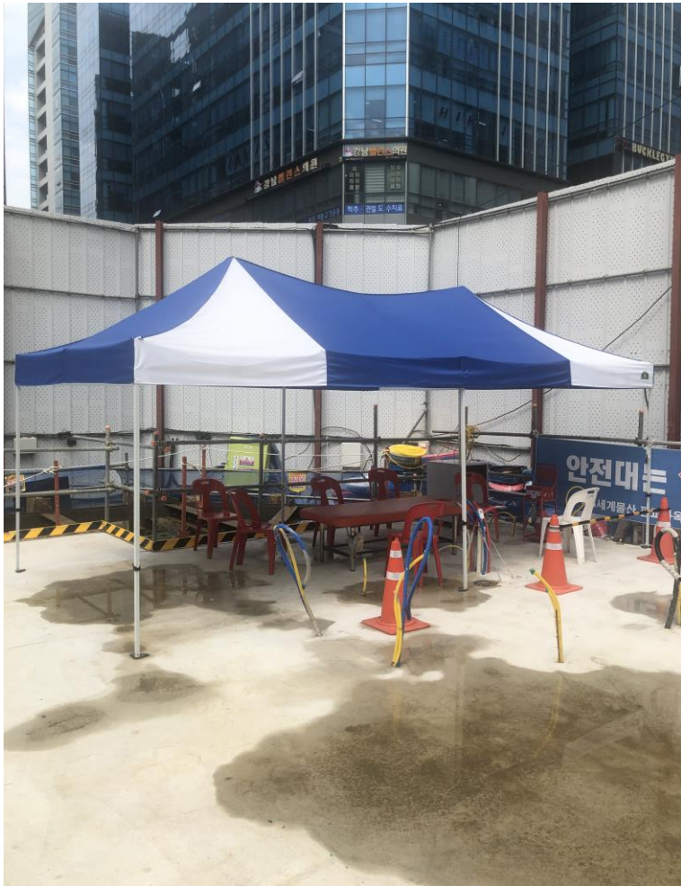
근로자 휴게시설 설치 우수
