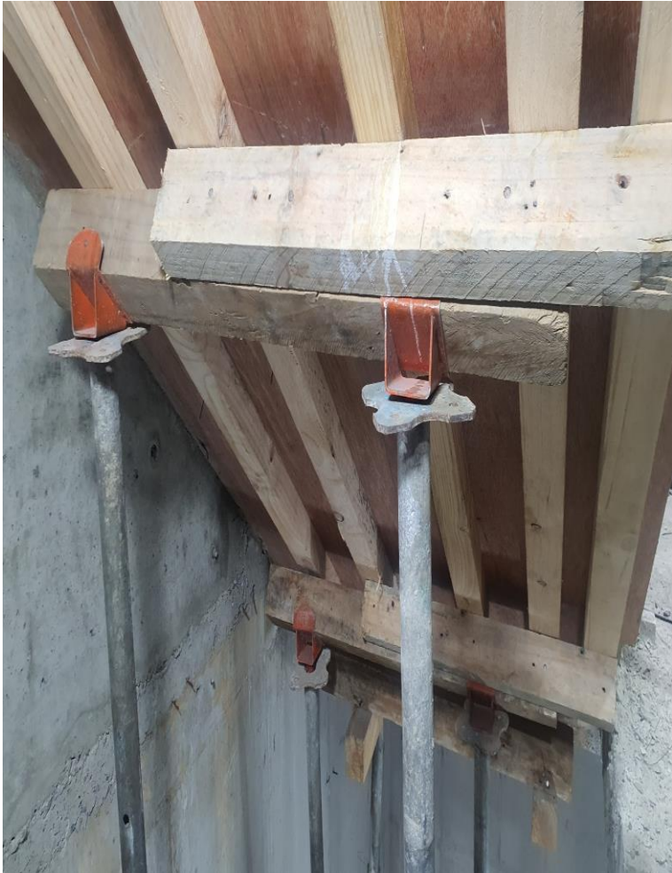
거푸집동바리 경사헤드 설치 우수
