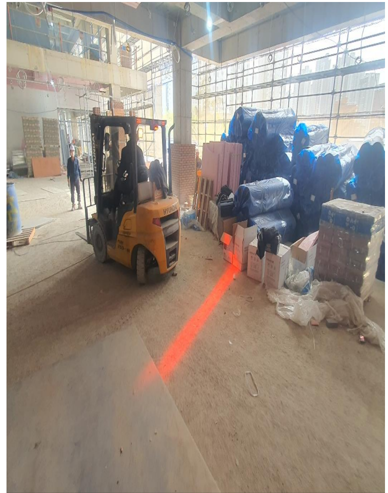
충돌방지장치 (레이저) 설치 우수
