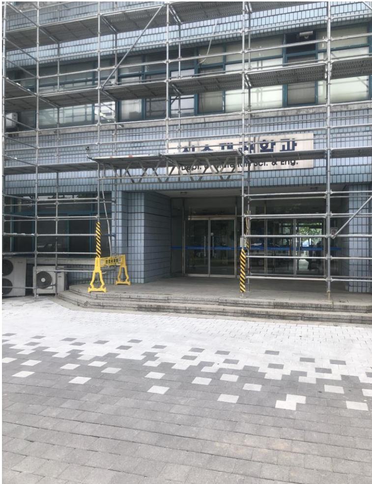
주 출입구 방호선반 설치 우수
