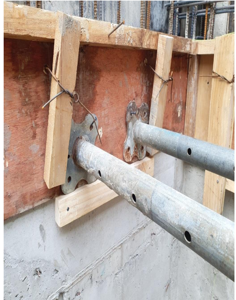
작업발판 거치용 서포트 하부 보강 실시완료
