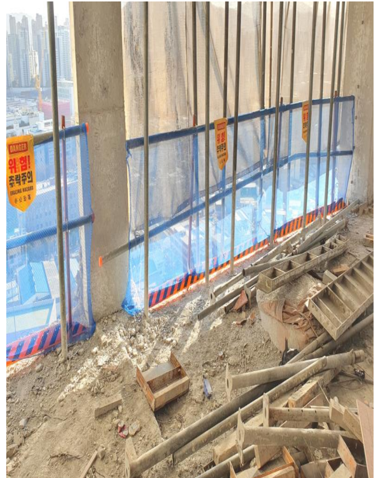
안전난간 수직망, 발끝막이판 설치완료
