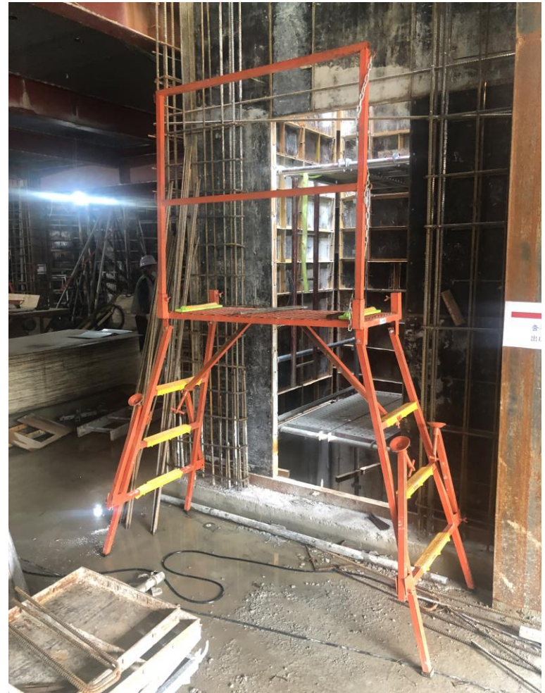
말비계 단부 안전난간 설치 우수
