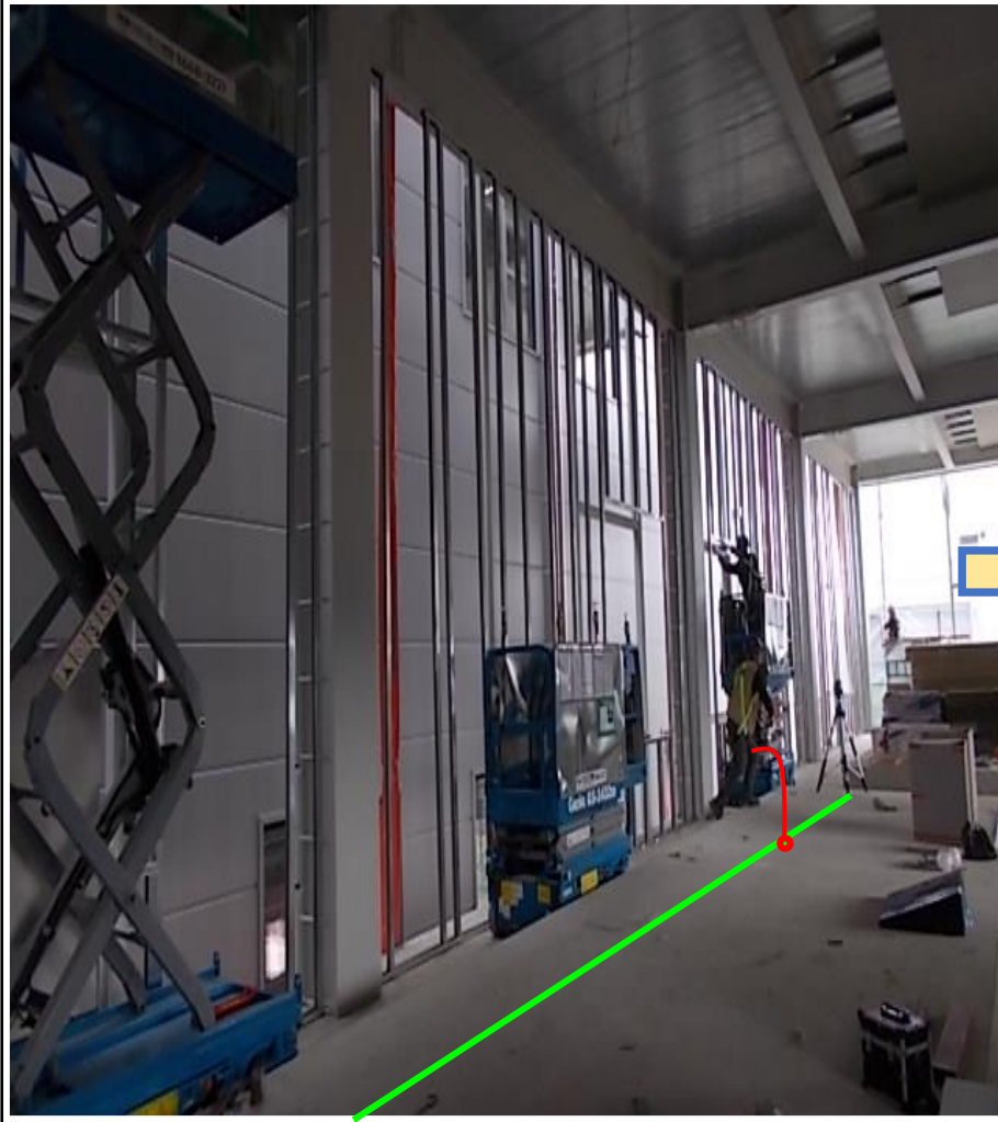
단부작업 안전대 부착설비 미 설치
