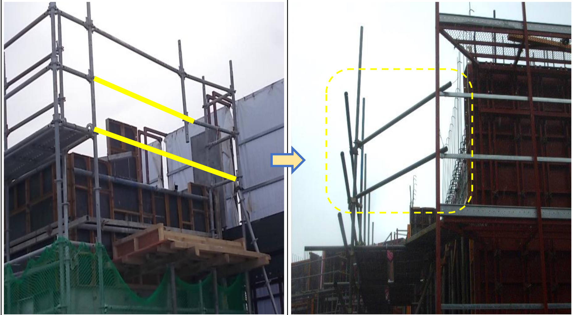
단부 안전난간 설치 미흡
