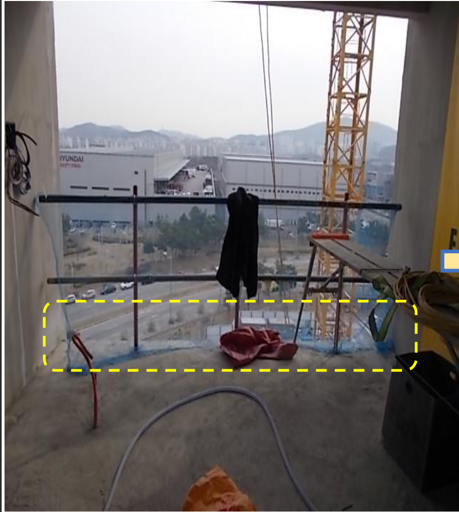
안전난간 발끝막이판(토보드) 미 설치
