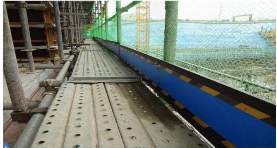
안전난간 발끝막이판(토보드) 미 설치
