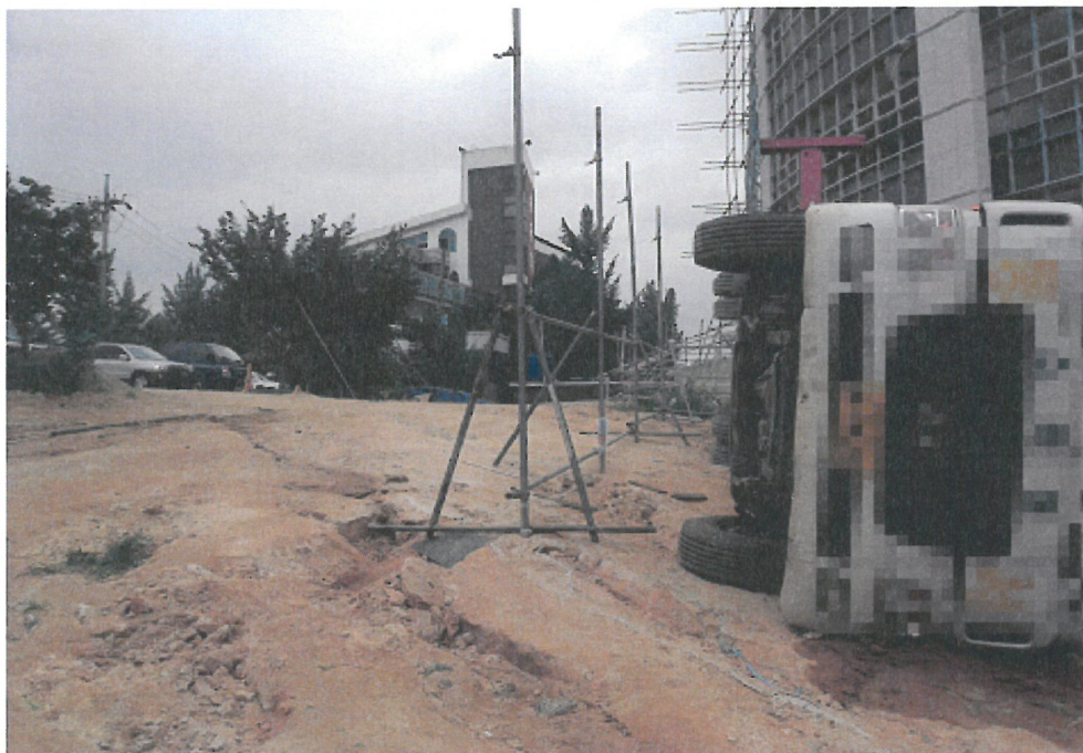
고소작업대 설치 지반상태(지반경사 9%)
