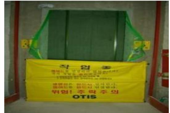
러셀망 및 차폐판을 이용한 출입구 추락 방지 시설(기타층은 러셀망만 설치)
