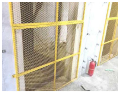
엘리베이터 개구부 안전난간 설치(예시)
