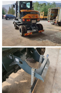
장비 후면에 보호가드 설치
