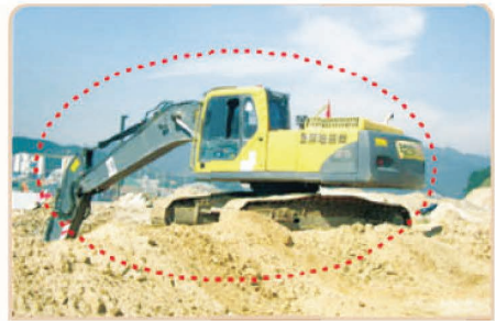
2 장비 제원 내 굴착작업
