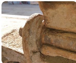
1 버킷 핀 홀 균열
