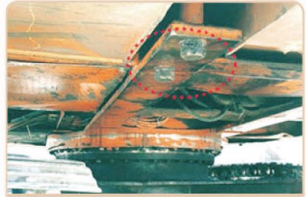
1 Weight Balance 고정볼트 설치
