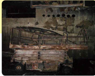
가설전등 스파크로 인한 우레탄폼 화재로 13명 사상
