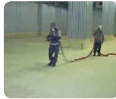
냉동창고 벽면·바닥 스프레이 시공
