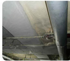
일반건축물 천장부 스프레이 시공
