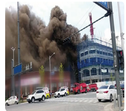
근린생활시설 신축공사 화재 ('16. 9. 10 사망4, 부상2)
