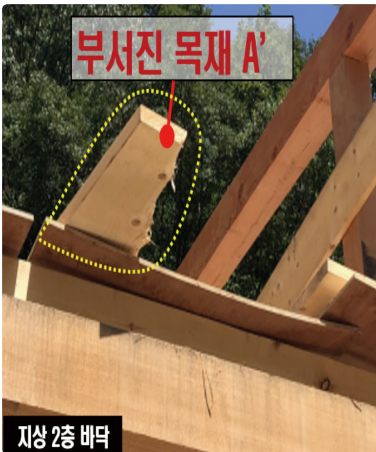
[사진2] 재해자와 함께 파단된 것으로 추정되는 목재 모습
