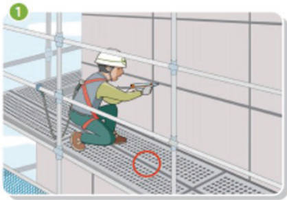
추락 또는 넘어짐 위험장소에 작업발판 설치
