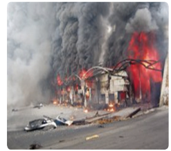
이천 물류 냉동창고 신축공사 화재 ('08. 1. 7 사망40, 부상10)
