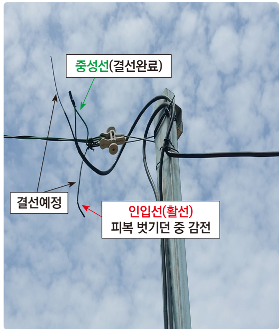
[사진2] 재해자가 작업중이던 장소 및 인입선 모습
