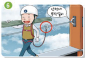
추락방호망 설치가 곤란한 경우 근로자에게 안전대 착용 및 사용
