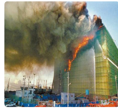
부산 냉동창고 신축공사 화재 ('98. 10. 29 사망27, 부상16)
