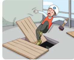
» 덮개 설치 불량
