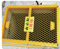
» 견고한 개구부 덮개 설치
