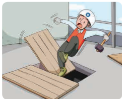
» 덮개 설치 불량
