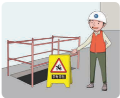
» 안전난간 및 경고표지 설치
