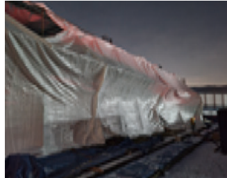
[콘크리트 보온양생 장소]
