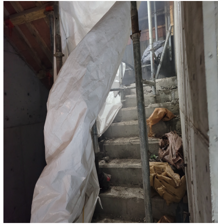
〈 콘크리트 양생 보양 장소 출입구 〉
