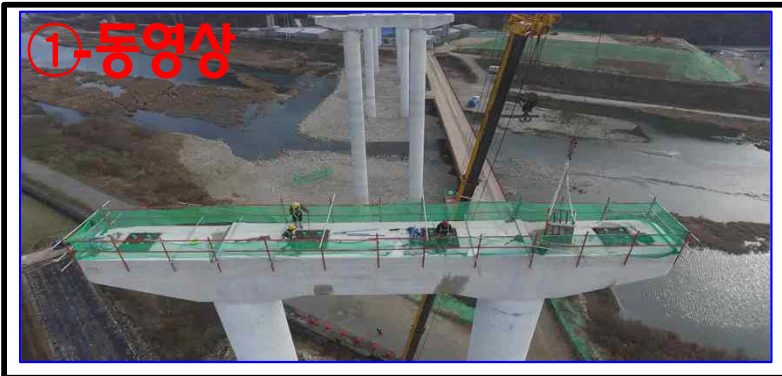
COPING FORM 해체 前 교좌장치 설치 추락위험 제거
