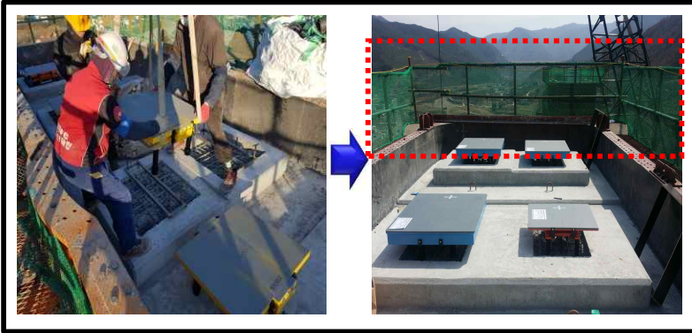
COPING FORM 해체 前 교좌장치 설치 추락위험 제거
