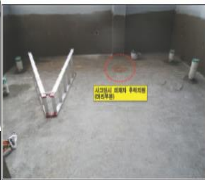
재해발생 현장전경 및 피해자 추락지점
